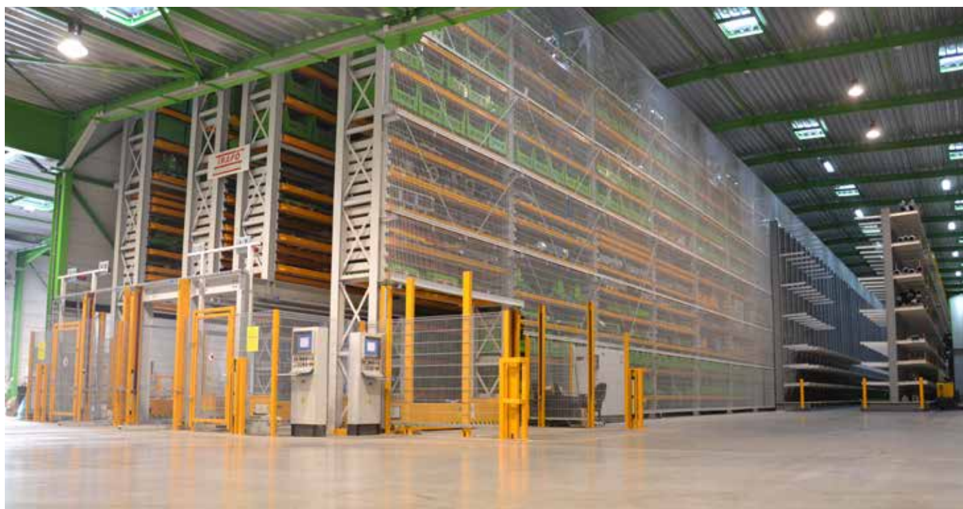
Almacенamientos automatizados de 28.000 m 3
